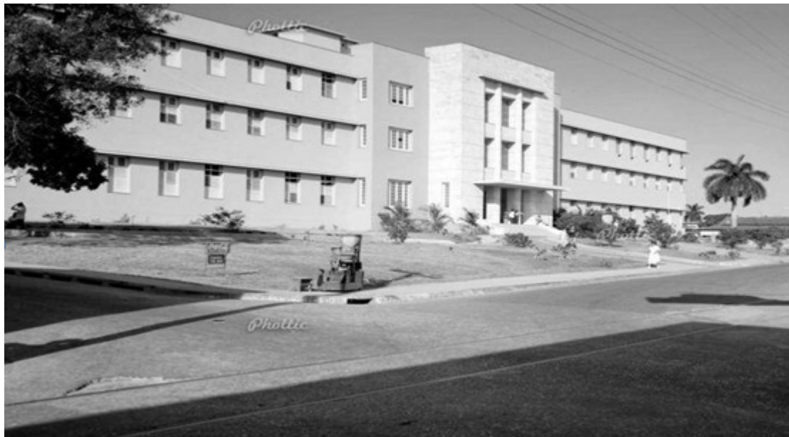
Fig. 2. Remodelación del hospital civil de Matanzas.
